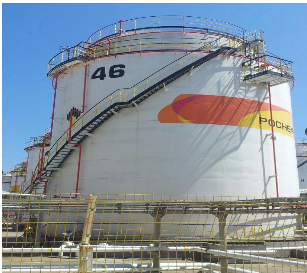
Рисунок 1 - Общий вид резервуаров с защитной стенкой РВС-2000, РВСП-2000
