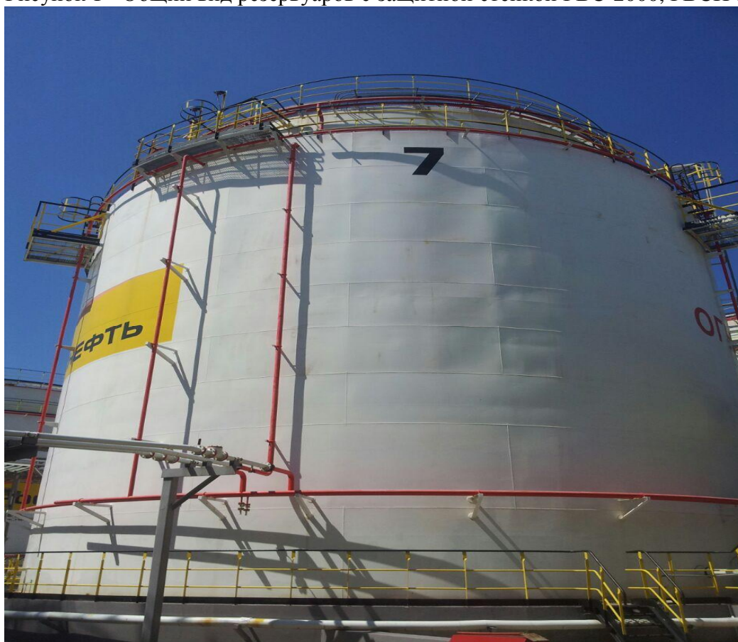
Рисунок 2 - Общий вид резервуара с защитной стенкой РВСП-3000
