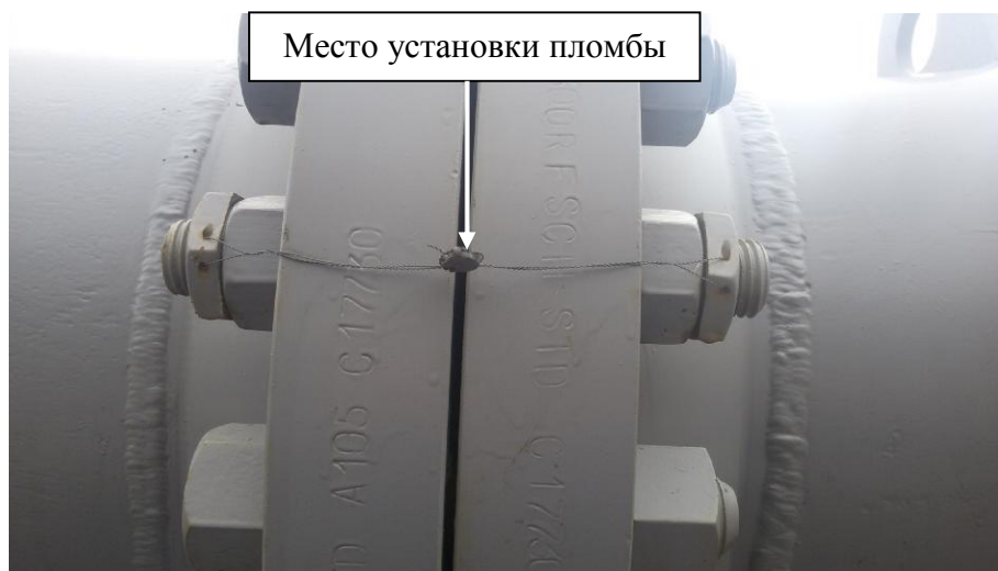
Рисунок 1 – Фланец калиброванного участка ТПУ. Схема пломбировки от несанкционированного доступа, обозначение места нанесения знака поверки
