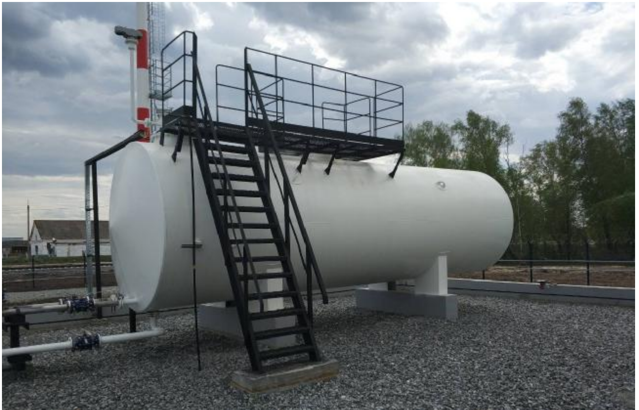
Рисунок 1 – Общий вид резервуара РГС-50
