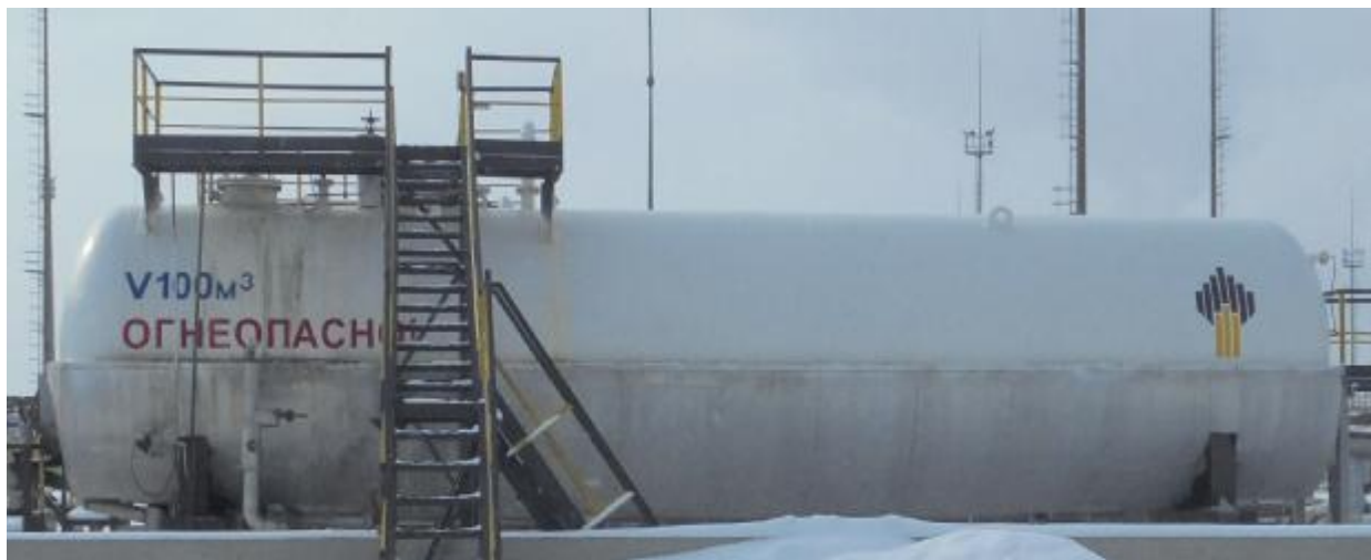
Рисунок 1 – Общий вид резервуара стального горизонтального цилиндрического РГС-100
