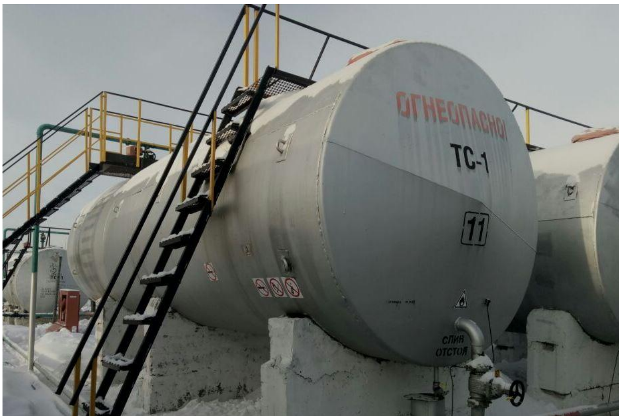
Рисунок 1 - Общий вид резервуара стального горизонтального цилиндрического РГС-50
