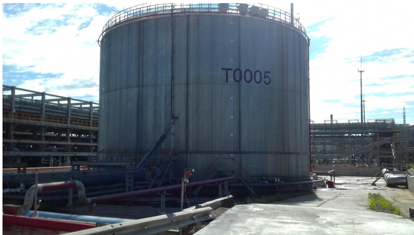
Рисунок 1 - Общий вид резервуара РВС-10000
