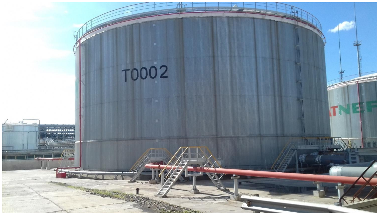
Рисунок 1 - Общий вид резервуара РВС-20000
