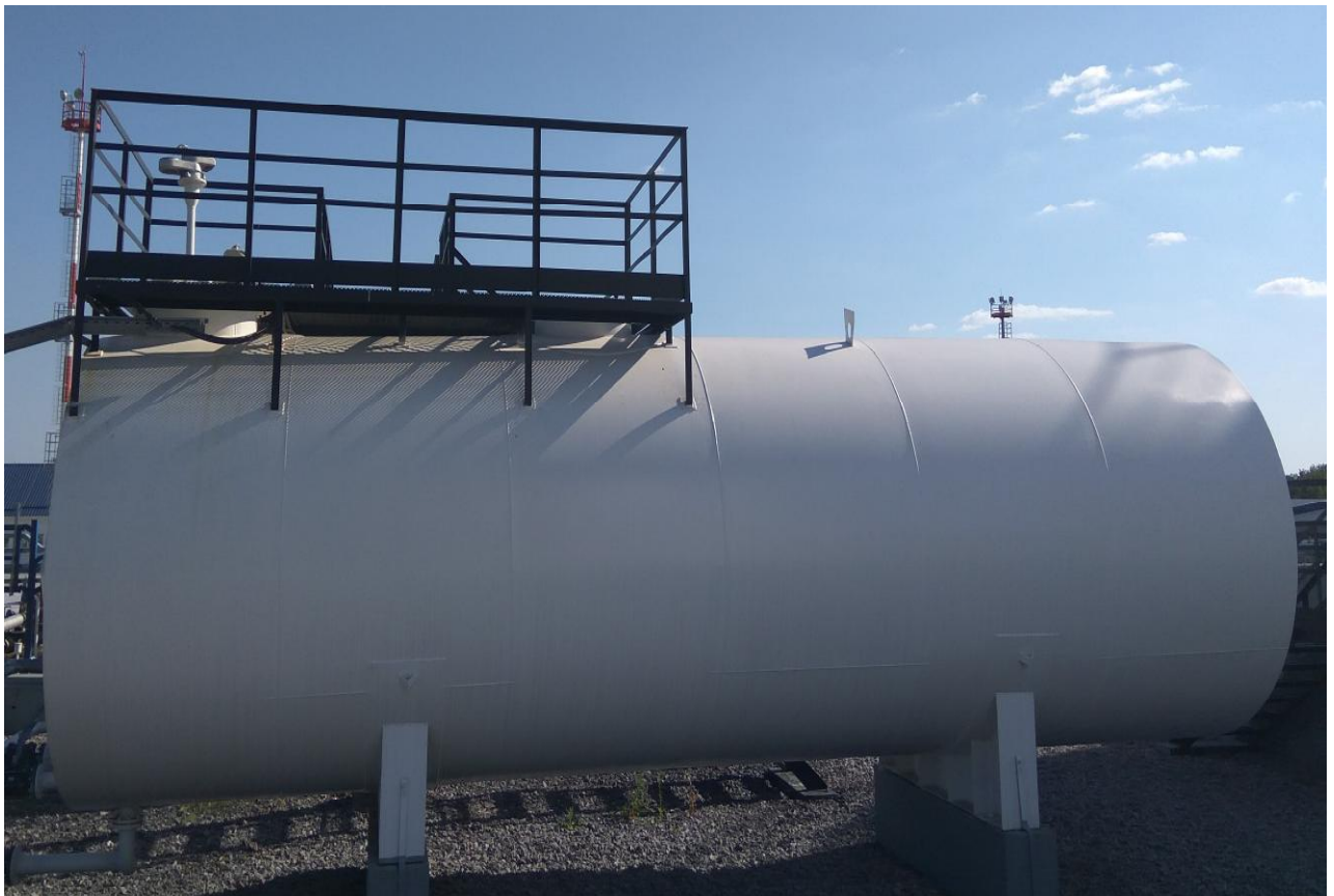
Рисунок 1 - Общий вид резервуара стального горизонтального цилиндрического РГС-50
