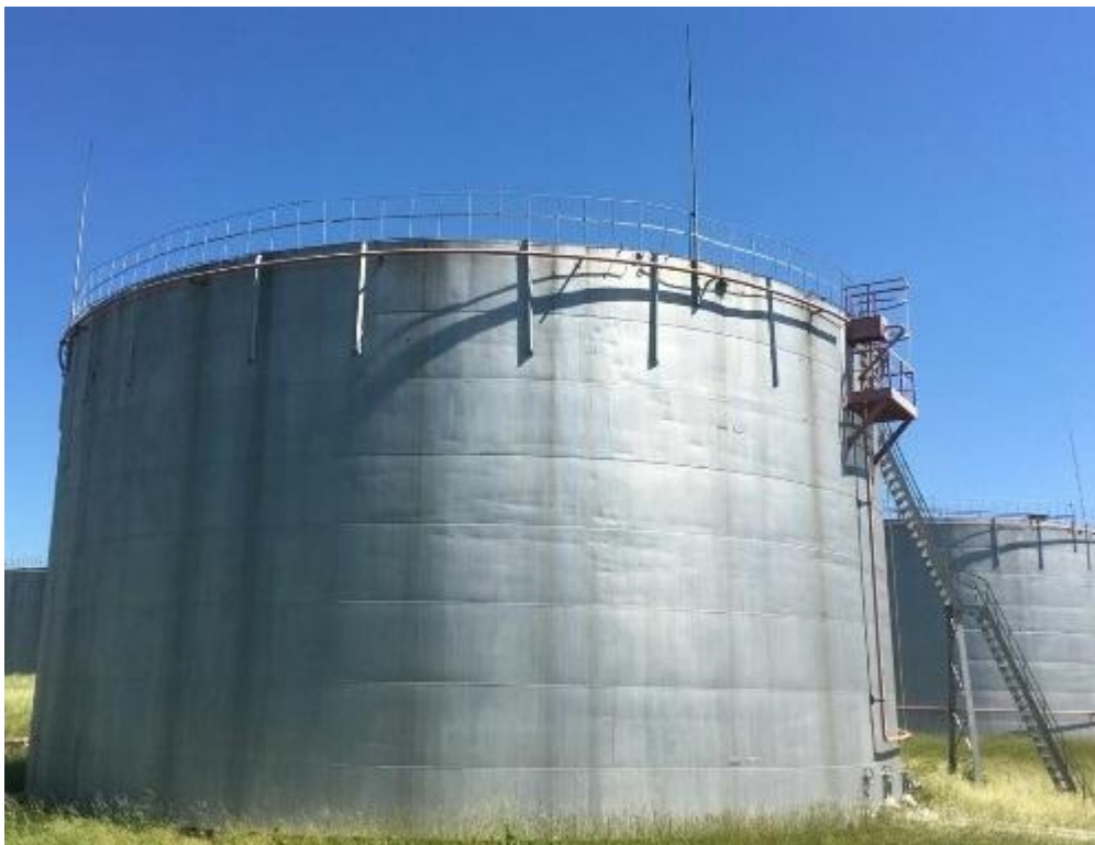
Рисунок 1 - Общий вид резервуаров
