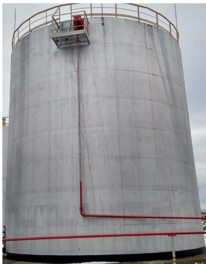
Рисунок 4 - Общий вид резервуара стального вертикального цилиндрического РВС-1000
