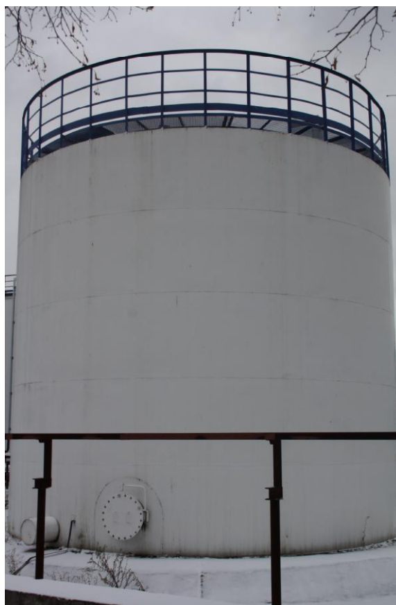
Рисунок 2 - Общий вид резервуара стального вертикального цилиндрического РВС-400
