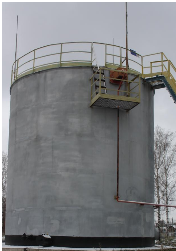
Рисунок 1 - Общий вид резервуара стального вертикального цилиндрического РВС-200
