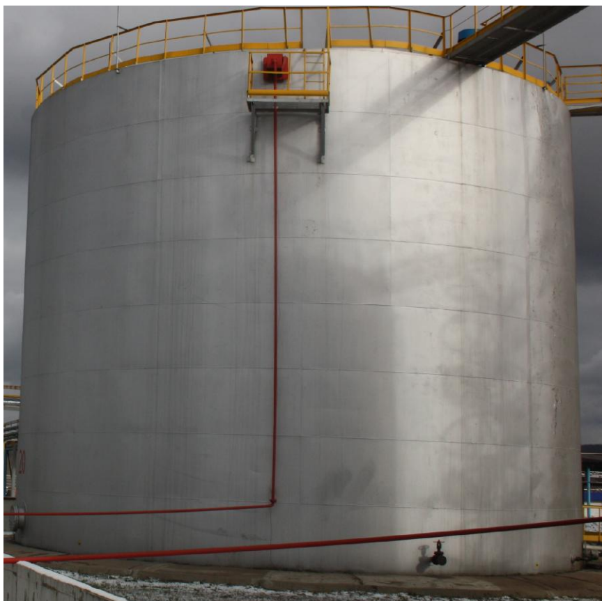
Рисунок 5 - Общий вид резервуара стального вертикального цилиндрического РВС-2000
