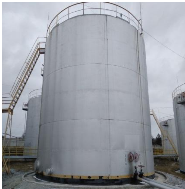
Рисунок 3 - Общий вид резервуара стального вертикального цилиндрического РВС-700
