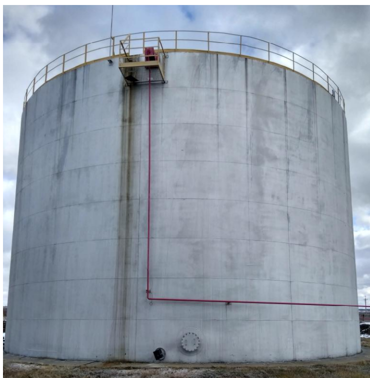
Рисунок 3 - Общий вид резервуара стального вертикального цилиндрического РВС-3000
