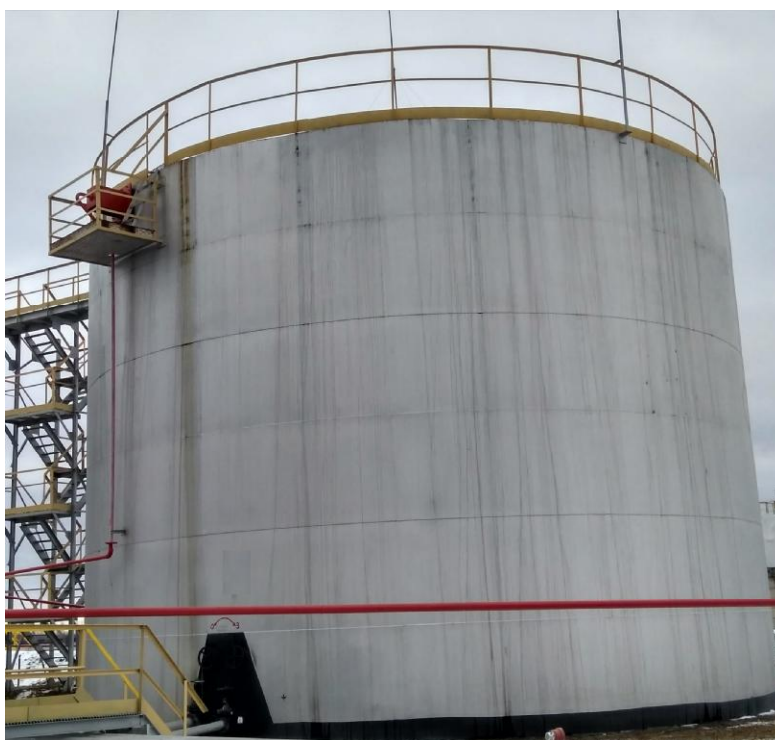
Рисунок 1 - Общий вид резервуара стального вертикального цилиндрического РВС-1000
