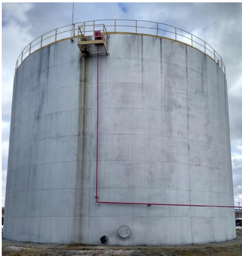
Рисунок 2 - Общий вид резервуара стального вертикального цилиндрического РВС-2000
