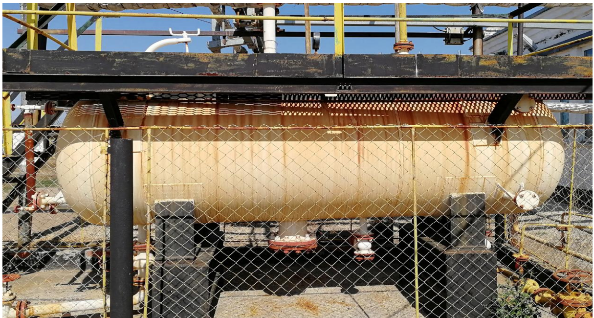
Рисунок 1 - Общий вид резервуара стального горизонтального цилиндрического РГС-5
