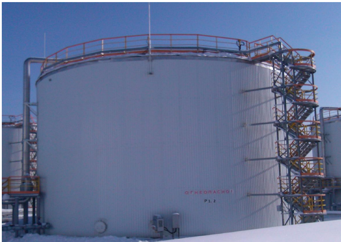
Рисунок 1 - Общий вид резервуара стального вертикального цилиндрического РВС-3000
