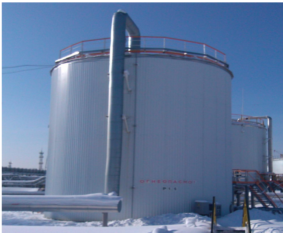
Рисунок 2 - Общий вид резервуара стального вертикального цилиндрического РВС-1000
