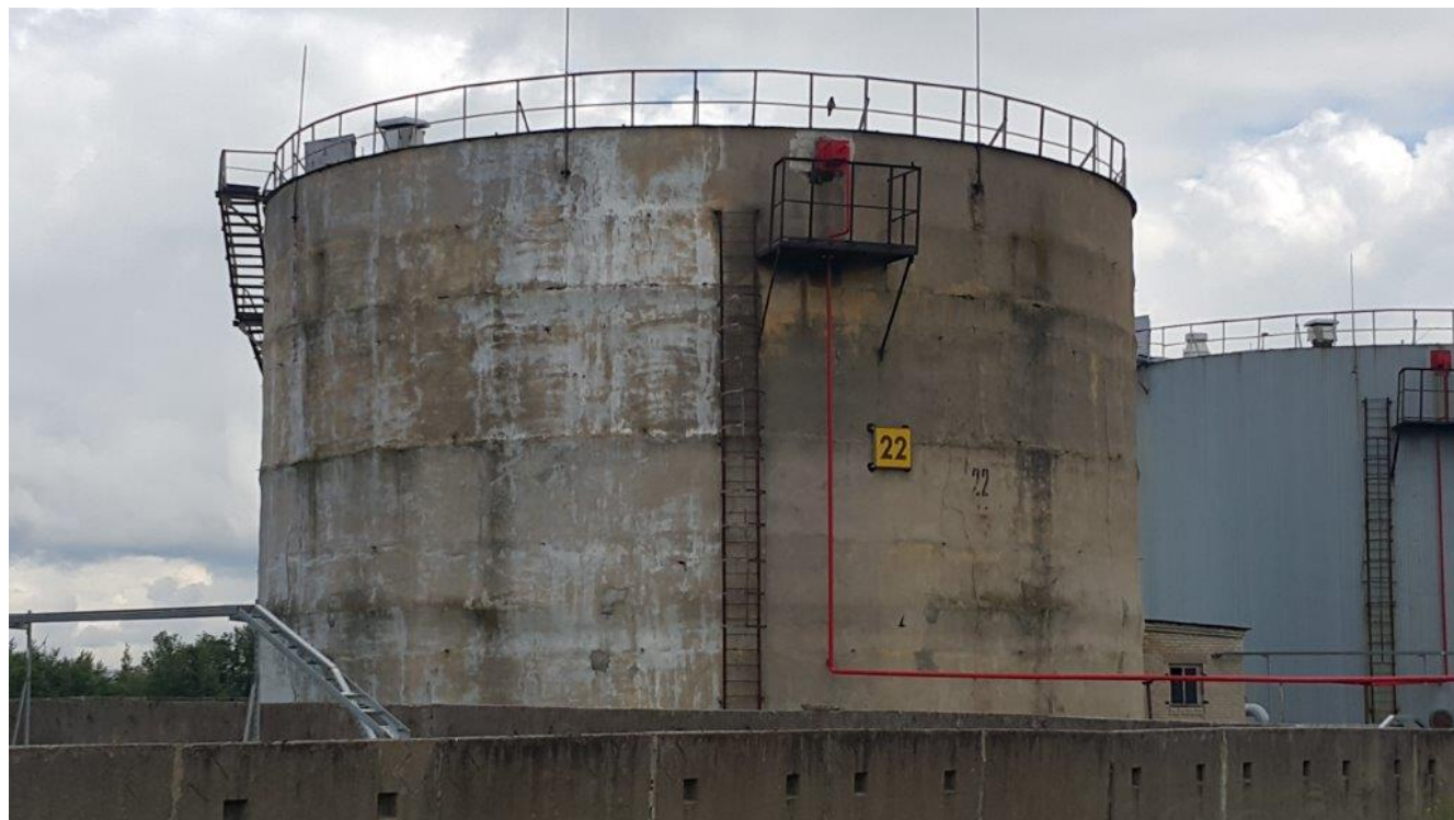
Рисунок 1 - Общий вид резервуара РВСт-3000
