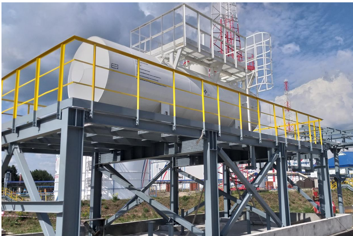
Рисунок 1 – Общий вид резервуара РГС-20
