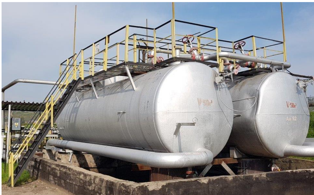
Рисунок 1 - Общий вид резервуара стального горизонтального цилиндрического РГС-50
