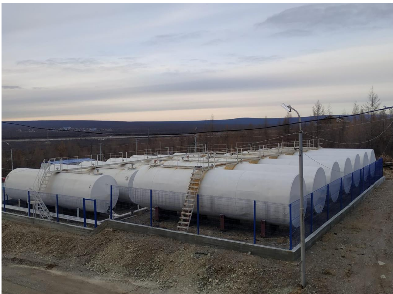
Рисунок 4 – Общий вид резервуаров РГС-60
