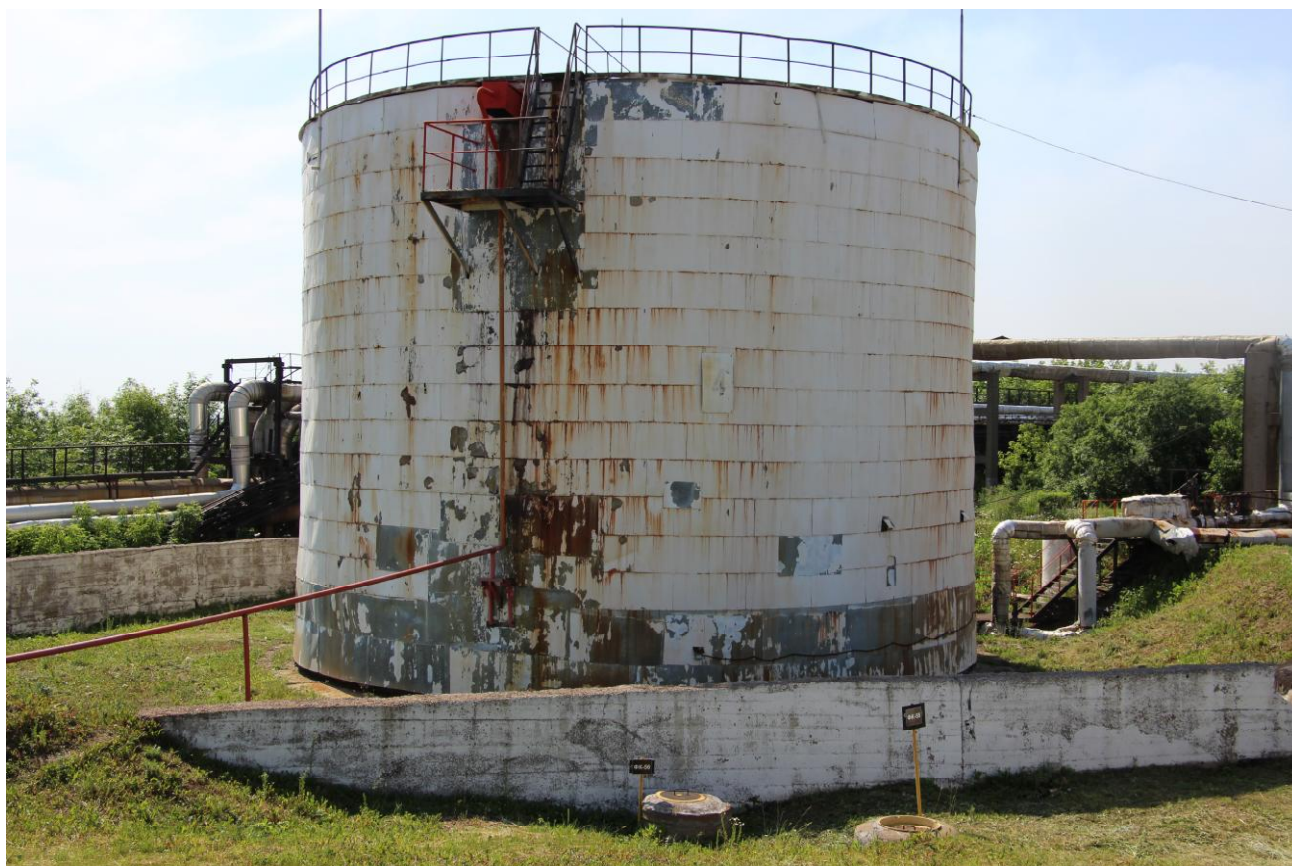
Рисунок 1 - Общий вид резервуара стального вертикального цилиндрического РВС-2000
