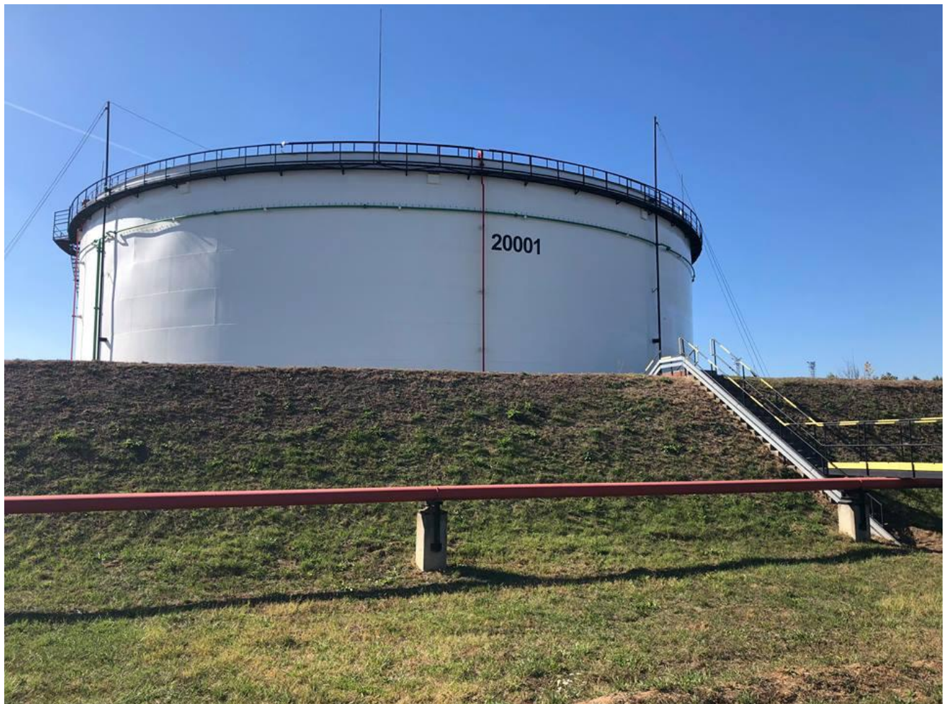
Рисунок 1 - Общий вид резервуара РВСПК-20000
