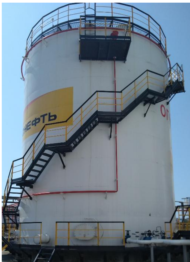
Рисунок 1 - Общий вид резервуара стального вертикального цилиндрического РВС-1000
