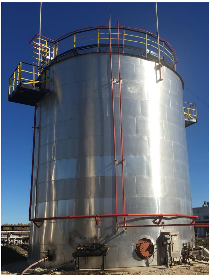
Рисунок 1 - Общий вид резервуара стального вертикального цилиндрического РВС-1000
