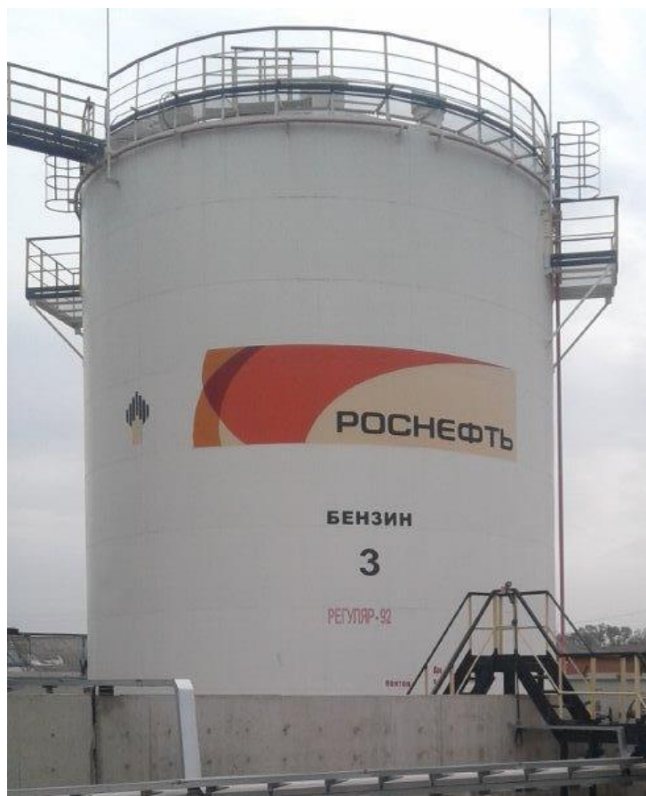
Рисунок 1 - Общий вид резервуара стального вертикального цилиндрического РВС-1000
