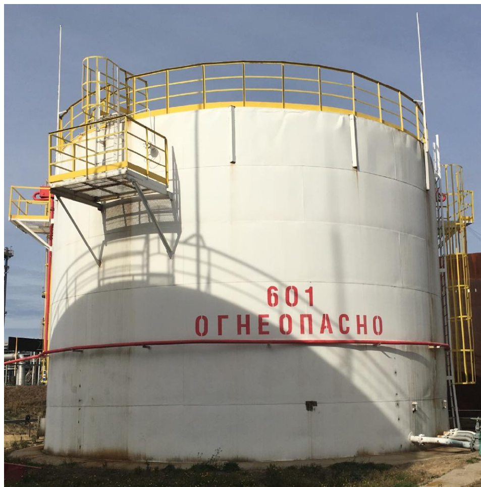
Рисунок 2 - Общий вид резервуара стального вертикального цилиндрического PVC-1000
