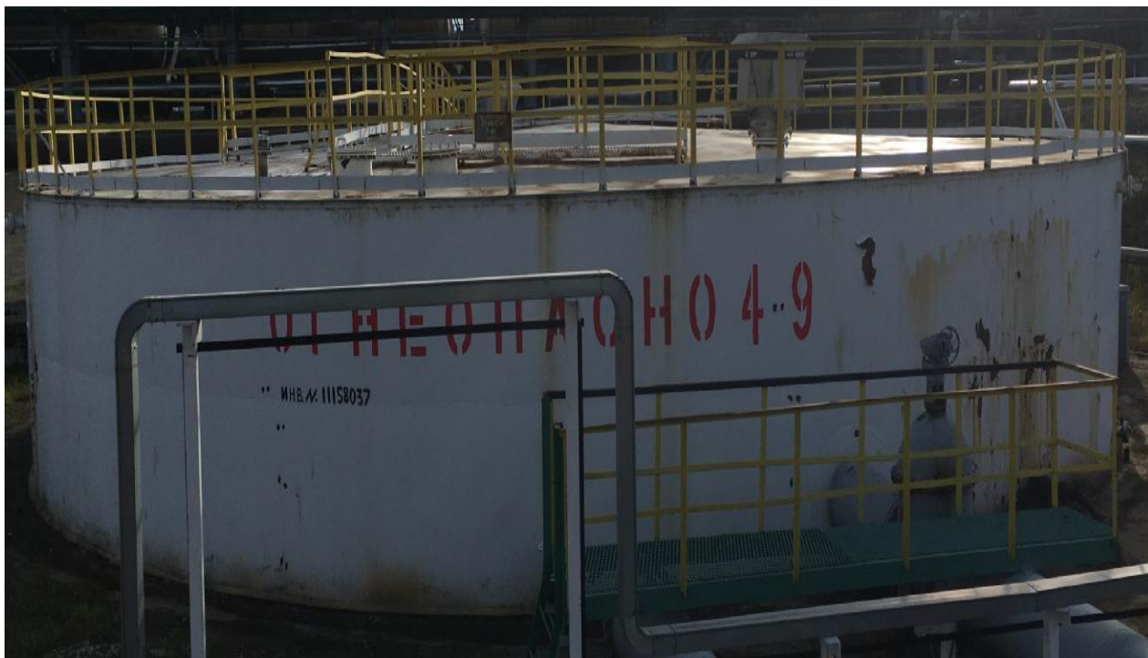
Рисунок 1 - Общий вид резервуара стального вертикального цилиндрического РВС-800
