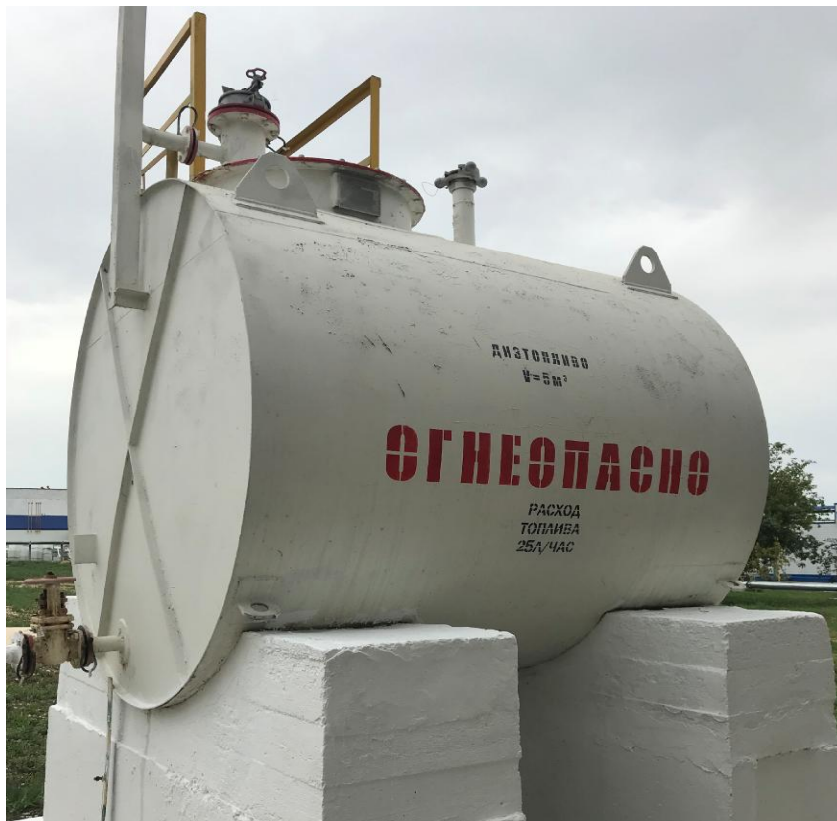
Рисунок 1 - Общий вид резервуара РГС-5 № 92
