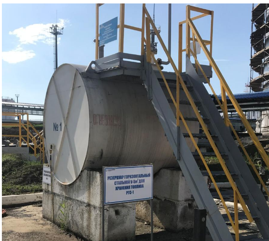
Рисунок 2 - Общий вид резервуара РГС-5 № 93
