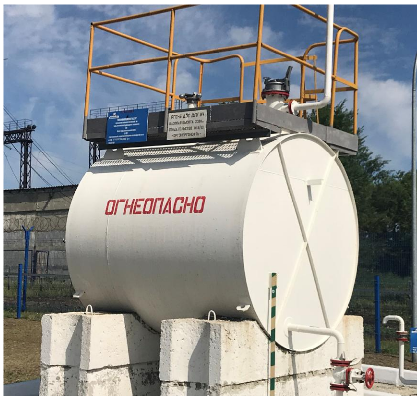
Рисунок 3 - Общий вид резервуара РГС-5 № 96
