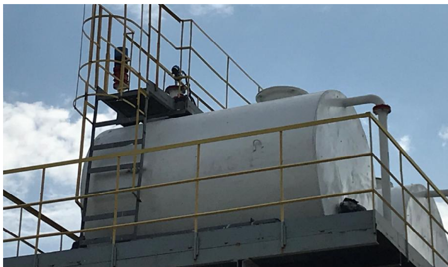
Рисунок 6 - Общий вид резервуара РГС-10 № 109
