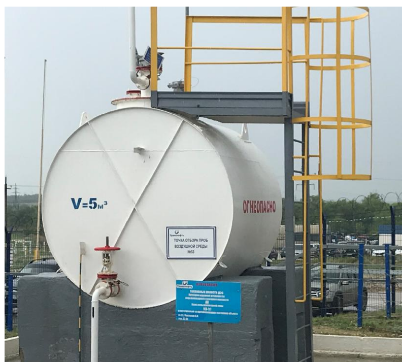
Рисунок 4 - Общий вид резервуара РГС-5 № 103
