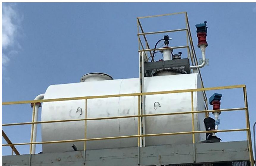
Рисунок 5 - Общий вид резервуара РГС-10 № 108
