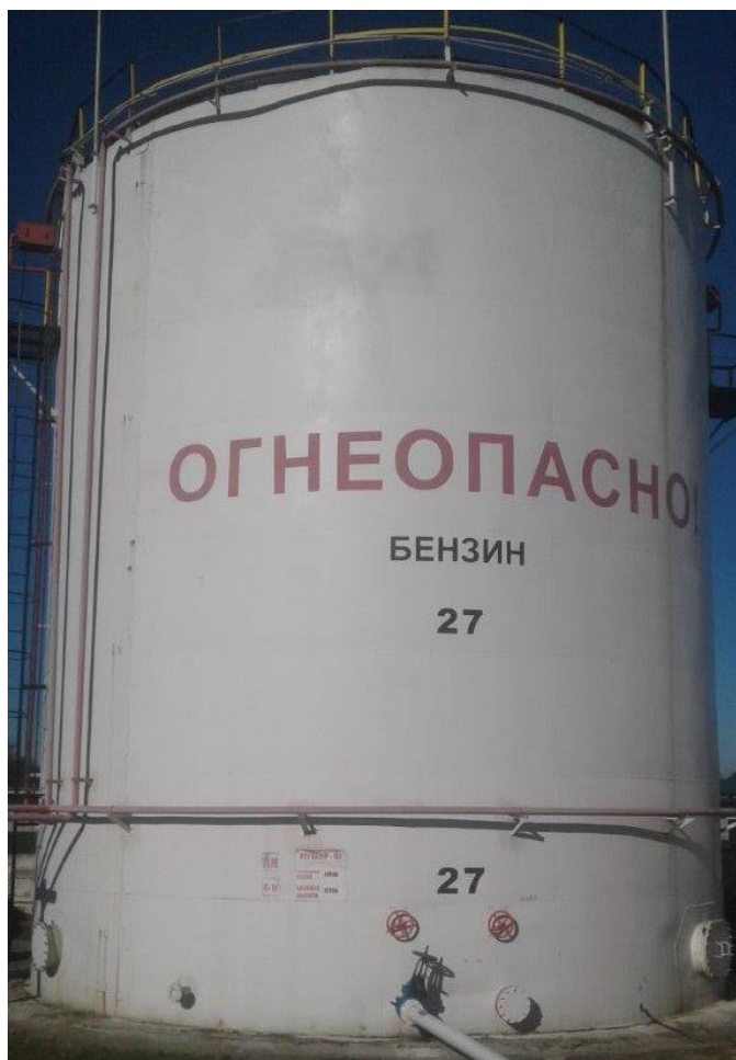
Рисунок 1 - Общий вид резервуара стального вертикального цилиндрического РВС-1000
