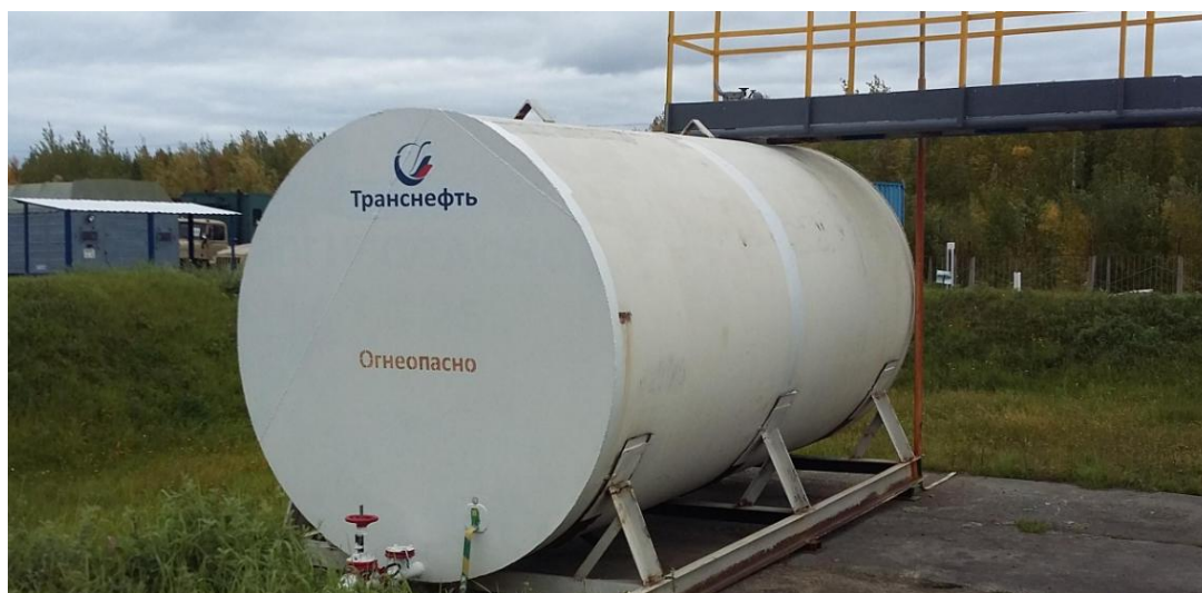
Рисунок 1 - Общий вид резервуаров
