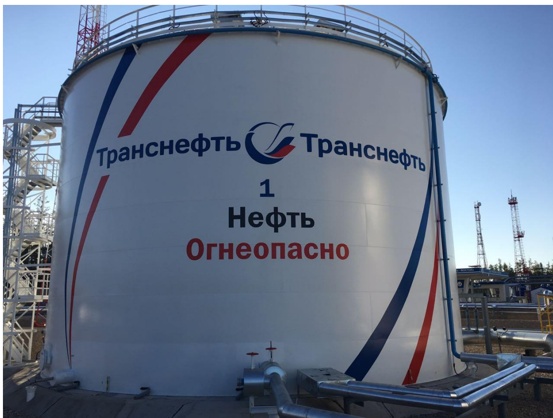
Рисунок 1 - Общий вид резервуаров вертикальных стальных цилиндрических РВС-3000
