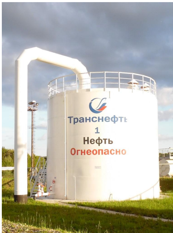
Рисунок 1 - Общий вид резервуара вертикального стального цилиндрического РВС-400
