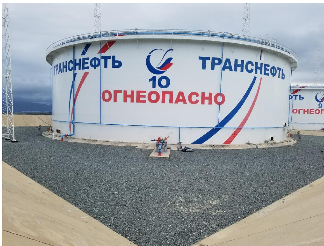
Рисунок 1 - Общий вид резервуара вертикального стального цилиндрического РВСПК-50000
