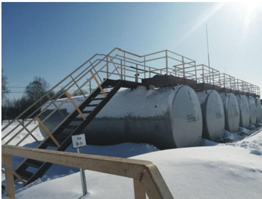
Рисунок 1 – Общий вид резервуаров РГС-75
