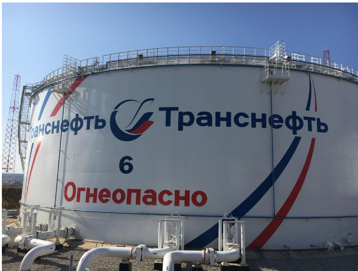
Рисунок 2 - Общий вид резервуара вертикального стального цилиндрического РВСП-50000
