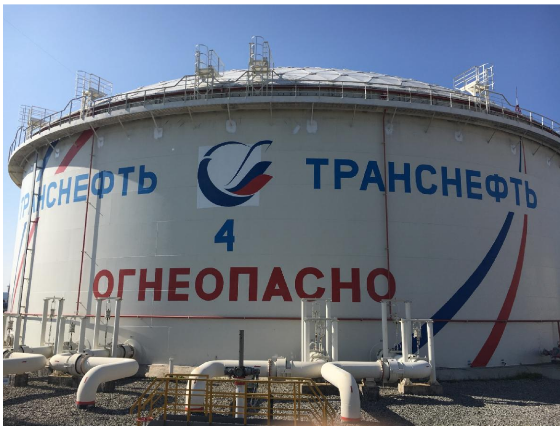
Рисунок 3 - Общий вид резервуара вертикального стального цилиндрического РВСПА-50000
