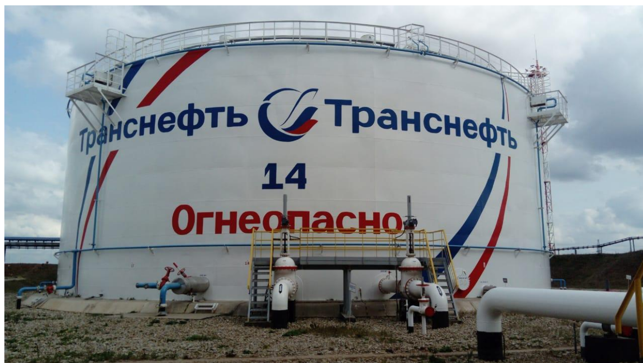
Рисунок 1 - Общий вид резервуара вертикального стального цилиндрического РВСП-10000
