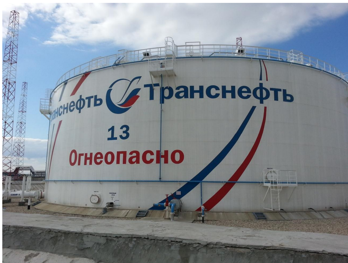
Рисунок 2 - Общий вид резервуара вертикального стального цилиндрического РВСП-20000
