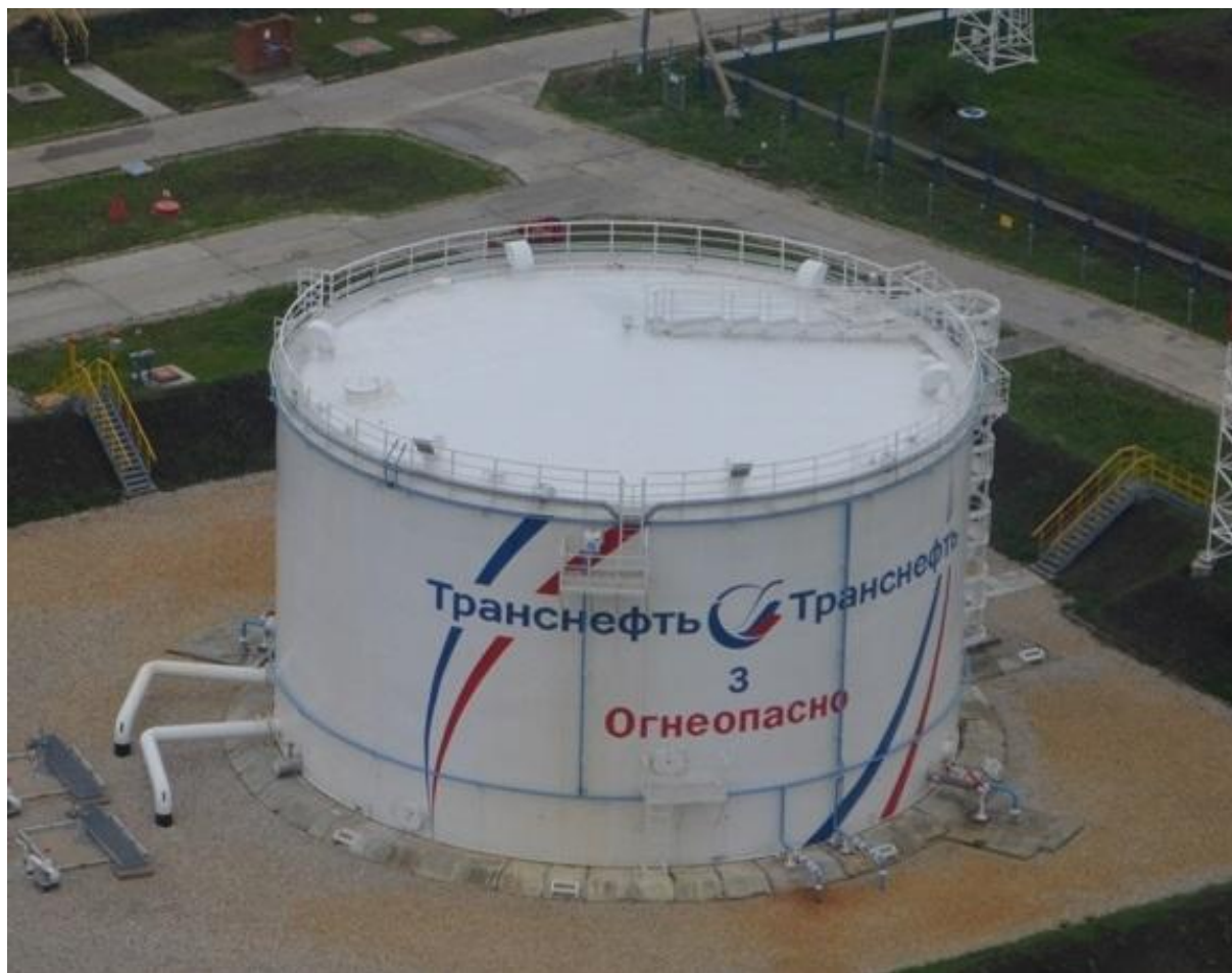
Рисунок 1 - Общий вид резервуара вертикального стального цилиндрического РВСП-5000
