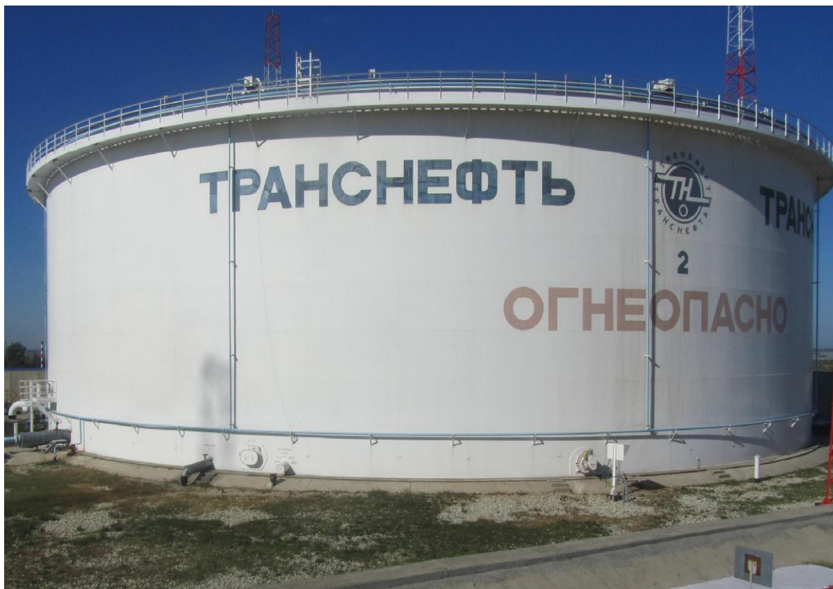
Рисунок 3 - Общий вид резервуара вертикального стального цилиндрического РВСПК-50000
