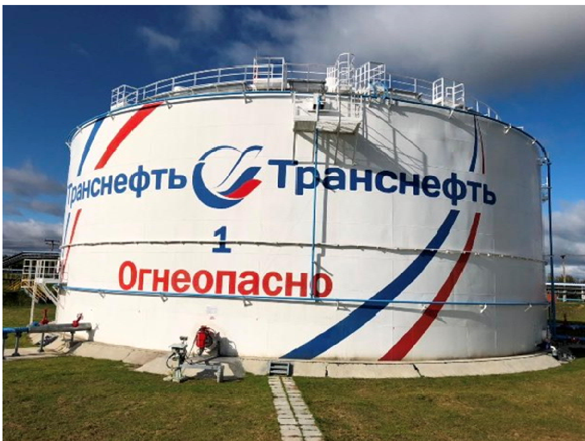
Рисунок 2 - Общий вид резервуара вертикального стального цилиндрического РВСП-10000
