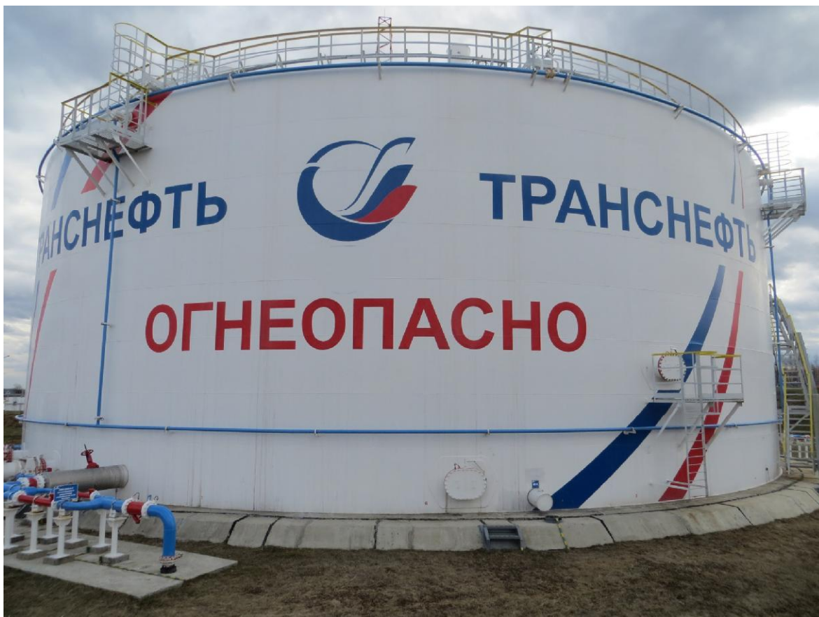
Рисунок 1 - Общий вид резервуара вертикального стального цилиндрического РВСП-5000
