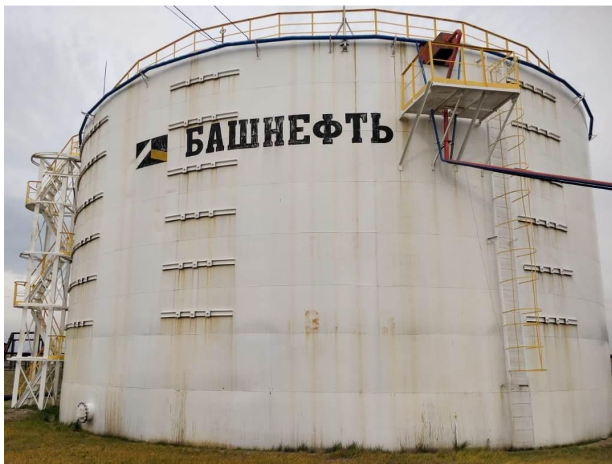
Рисунок 5 - Общий вид резервуара стального вертикального цилиндрического РВС-4000
