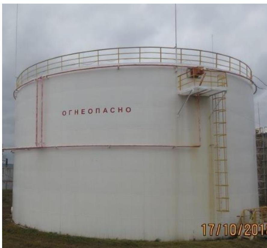
Рисунок 6 - Общий вид резервуара стального вертикального цилиндрического РВС-5000
