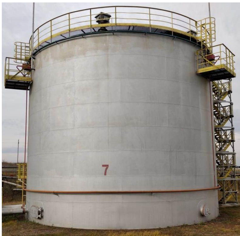
Рисунок 3 - Общий вид резервуара стального вертикального цилиндрического РВС-2000
