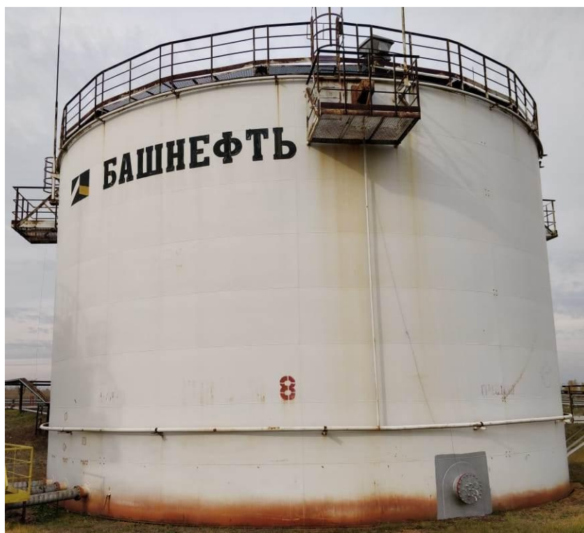
Рисунок 4 - Общий вид резервуара стального вертикального цилиндрического РВС-3000
