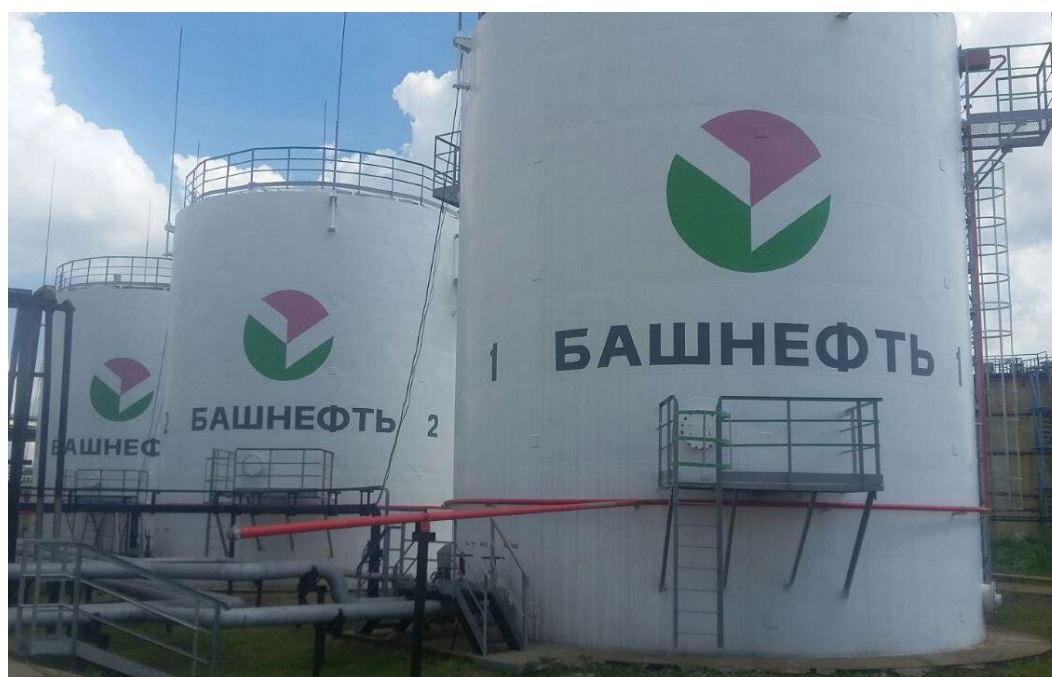
Рисунок 2 - Общий вид резервуара стального вертикального цилиндрического РВС-1000
