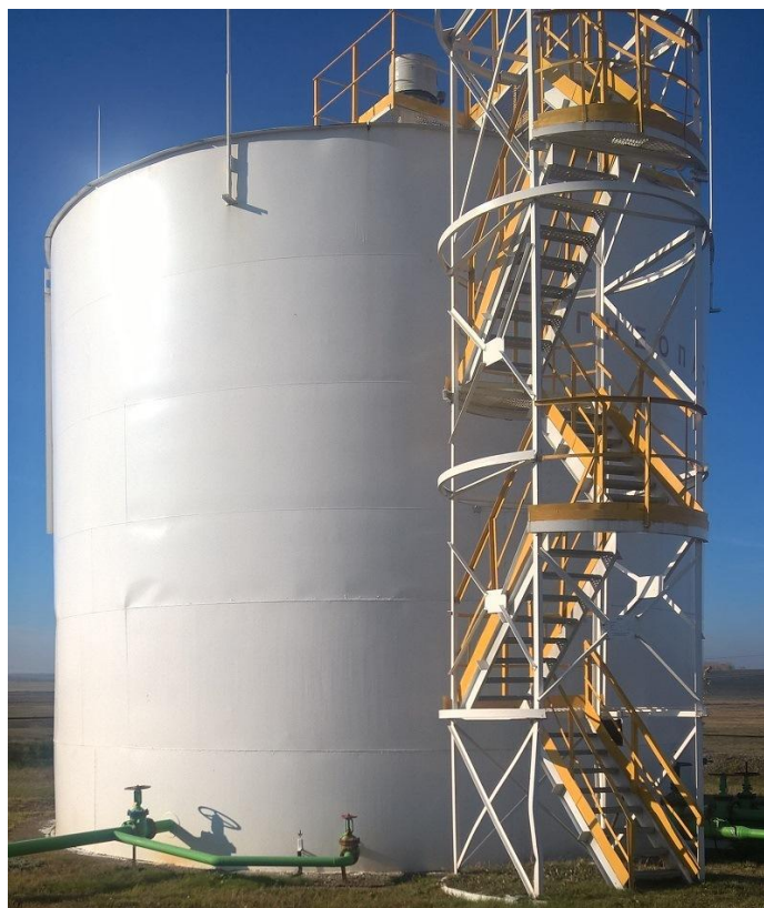
Рисунок 1 - Общий вид резервуара стального вертикального цилиндрического РВС-700
