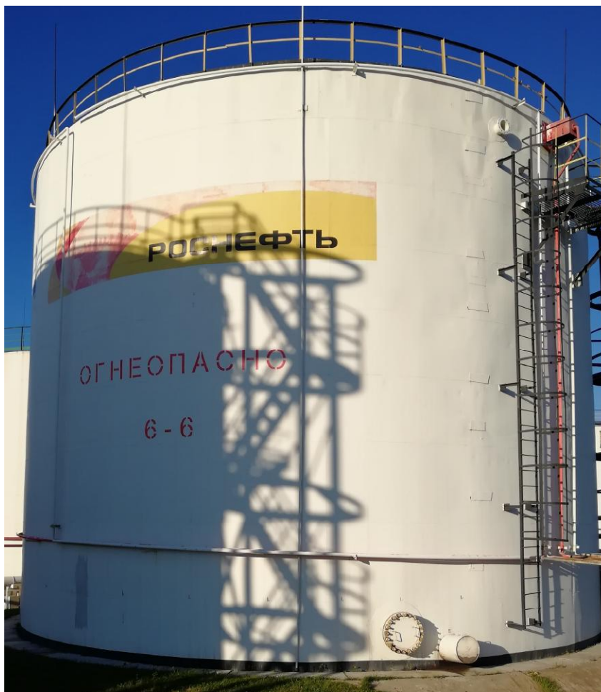
Рисунок 4 - Общий вид резервуара стального вертикального цилиндрического РВС-2000
