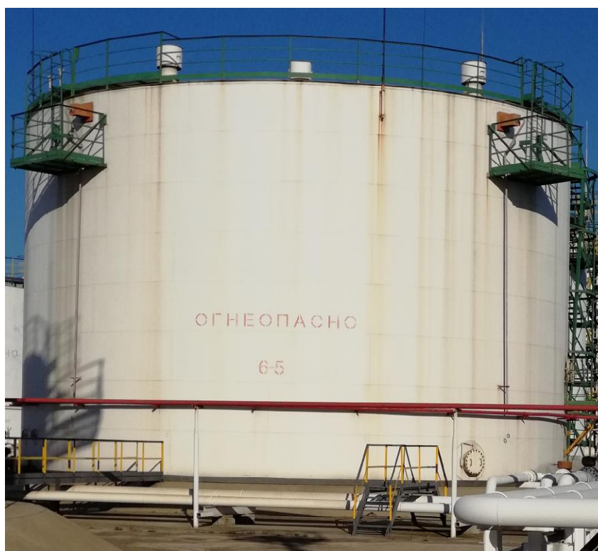
Рисунок 5 - Общий вид резервуара стального вертикального цилиндрического РВСП-3000
