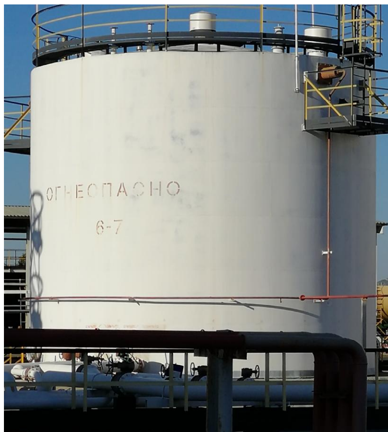
Рисунок 1 - Общий вид резервуара стального вертикального цилиндрического РВСП-700
