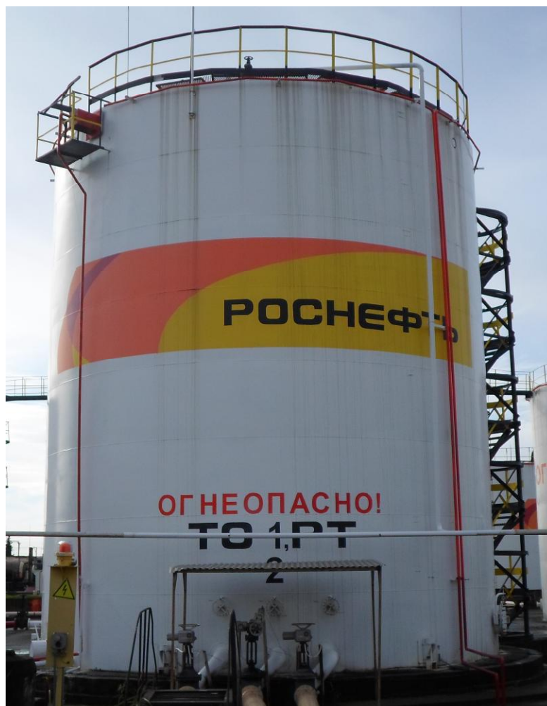
Рисунок 1 - Общий вид резервуара стального вертикального цилиндрического РВС-1000
