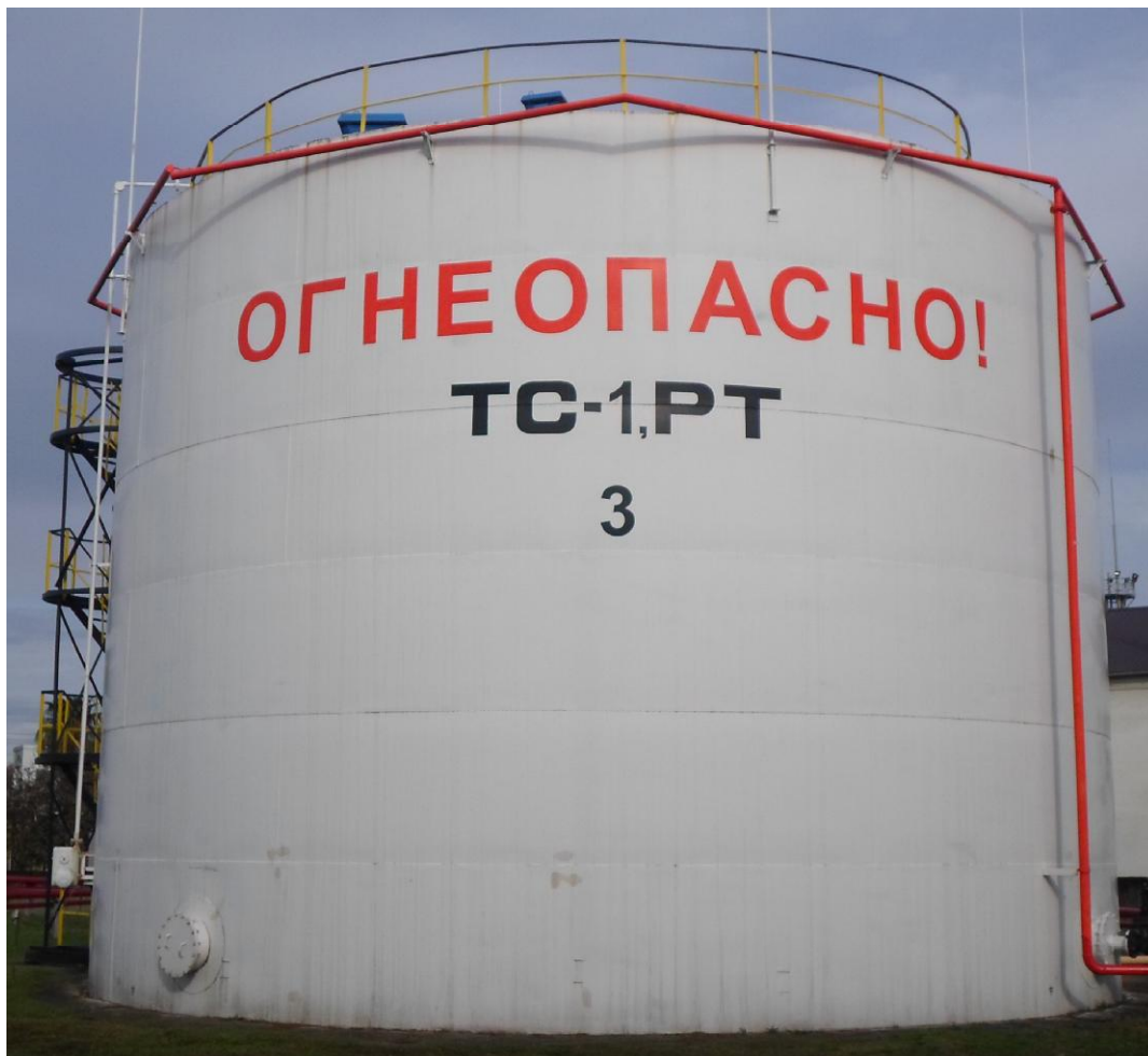
Рисунок 1 - Общий вид резервуара стального вертикального цилиндрического РВС-1000
