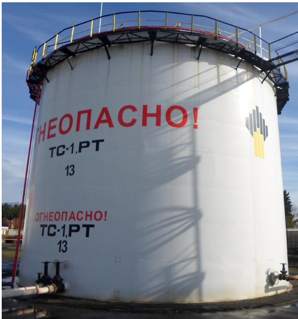
Рисунок 2 - Общий вид резервуара стального вертикального цилиндрического РВС-2000
