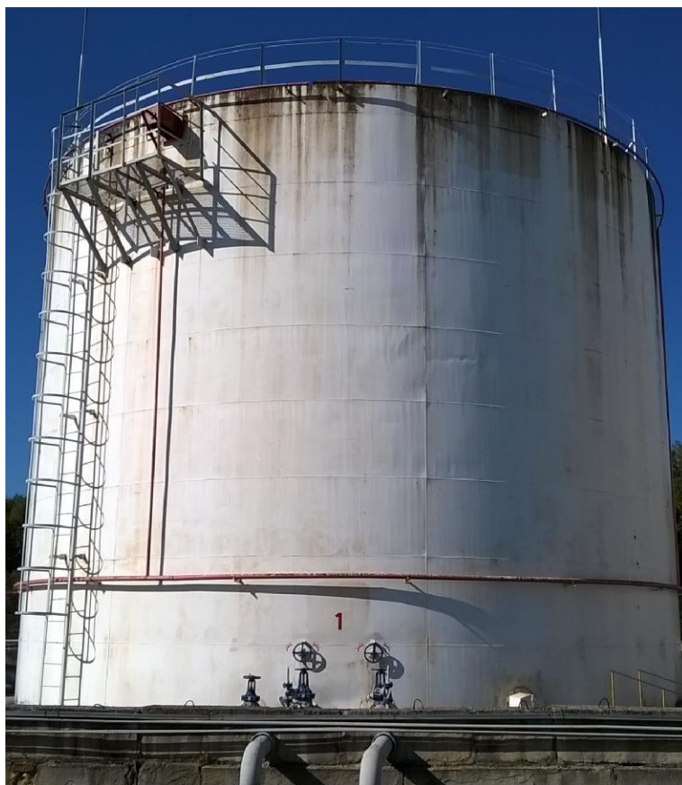
Рисунок 2 - Общий вид резервуара стального вертикального цилиндрического РВС-2000
