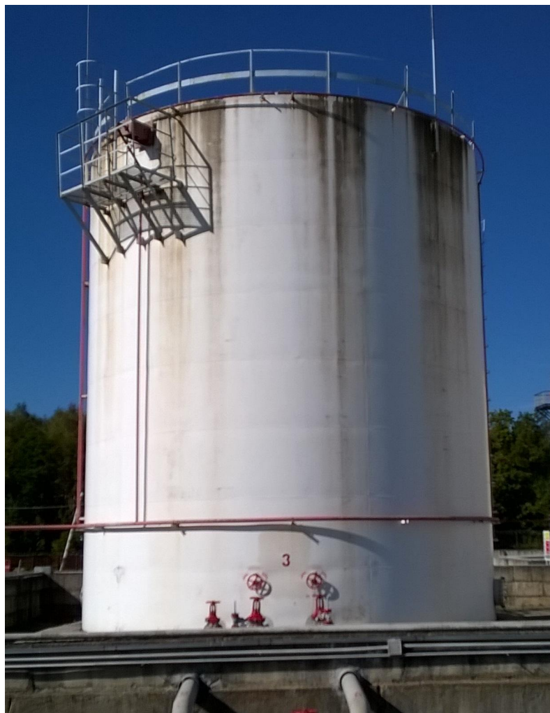
Рисунок 1 - Общий вид резервуара стального вертикального цилиндрического РВС-1000
