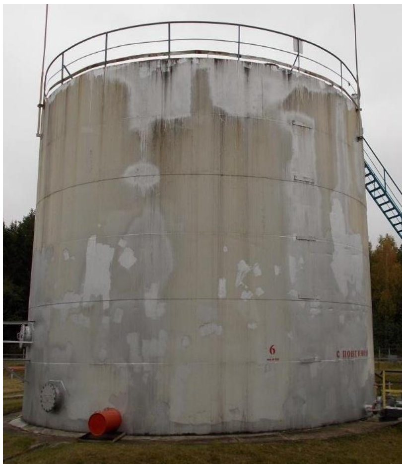
Рисунок 2 - Общий вид резервуара стального вертикального цилиндрического РВС-700
