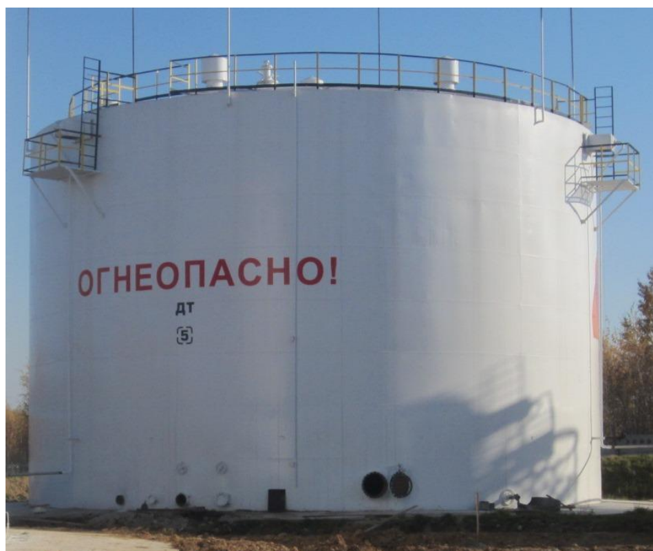
Рисунок 2 - Общий вид резервуара стального вертикального цилиндрического РВС-3000
