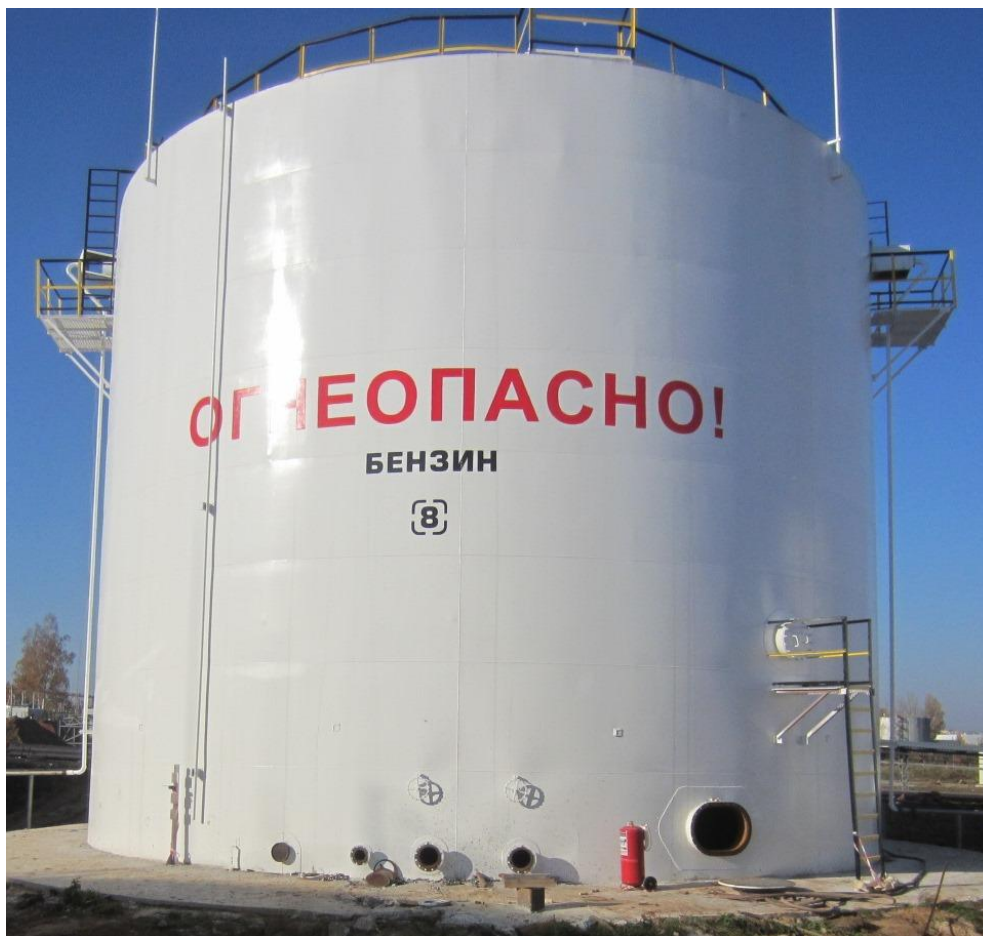
Рисунок 1 - Общий вид резервуара стального вертикального цилиндрического РВС-2000
