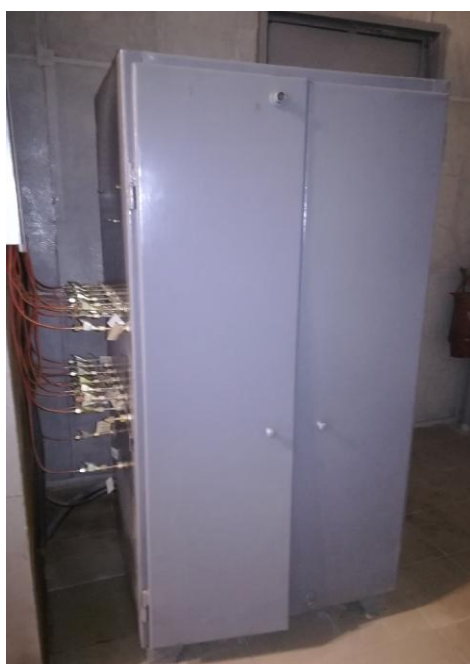
Рисунок 2 - Шкаф датчиков давления (ШкДД) Рисунок 2.1 – ШкДД (открытый)
