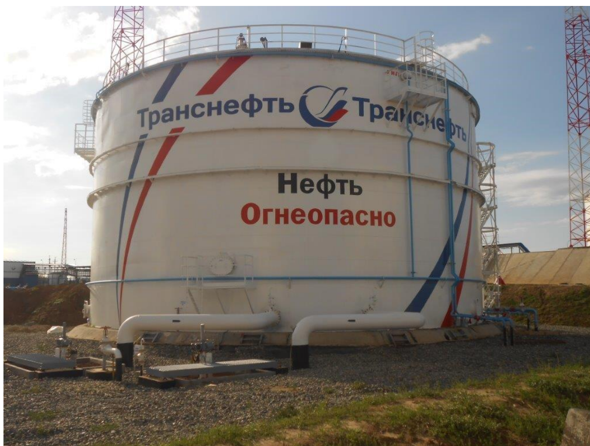
Рисунок 2 - Общий вид резервуара вертикального стального цилиндрического РВСП-5000
