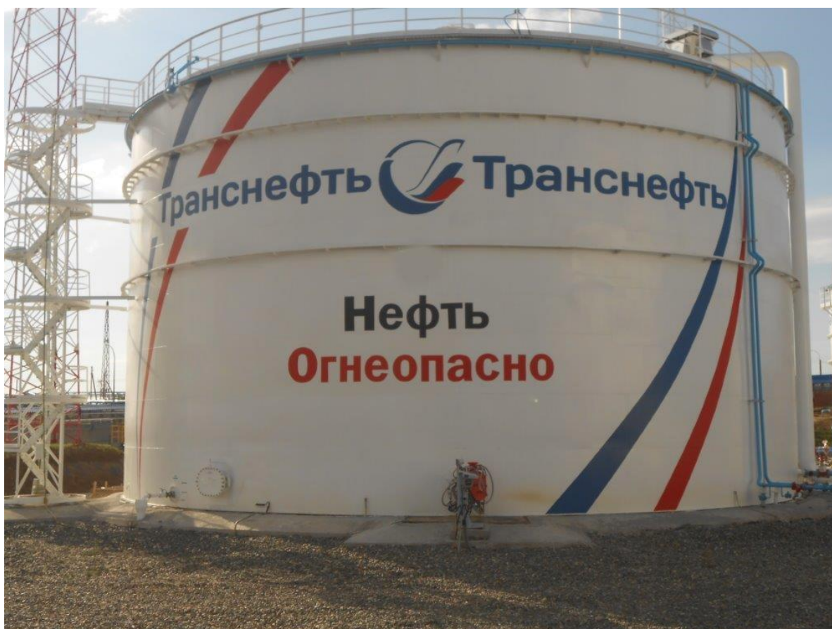
Рисунок 1 - Общий вид резервуара вертикального стального цилиндрического РВС-5000
