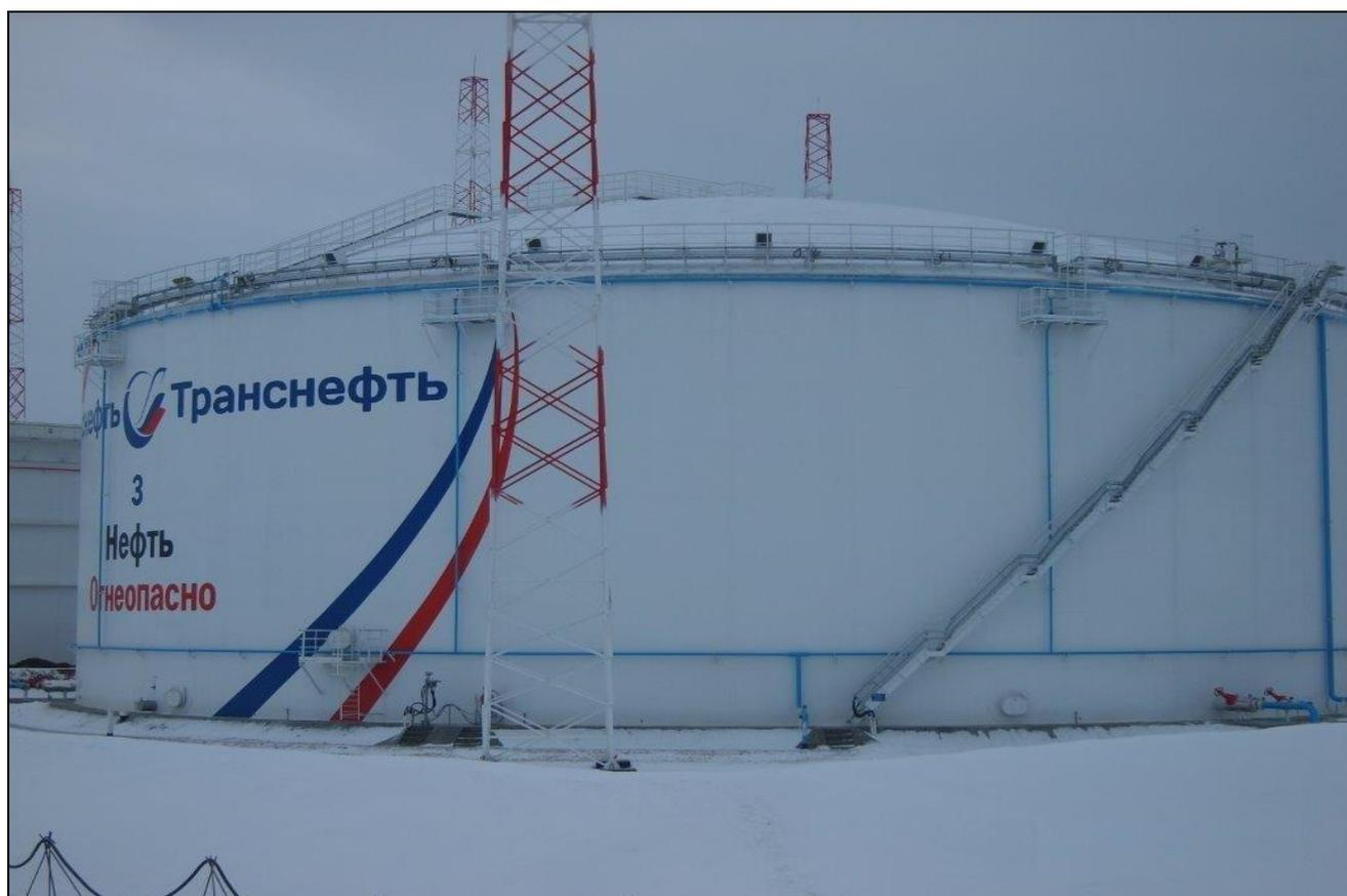
Рисунок 3 - Общий вид резервуаров вертикальных стальных цилиндрических РВСП-50000
