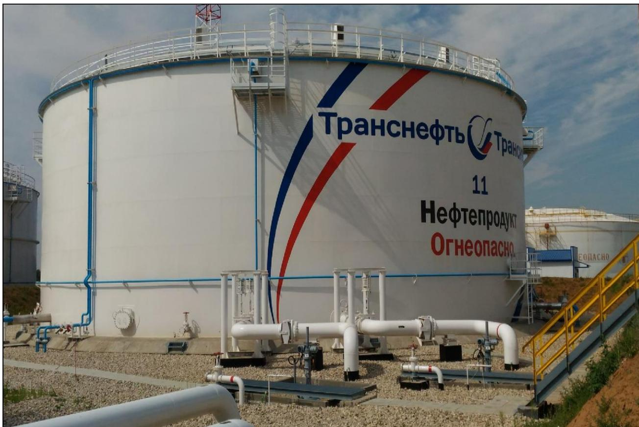
Рисунок 1 - Общий вид резервуаров вертикальных стальных цилиндрических РВСП-10000
