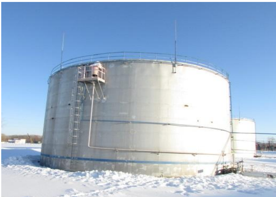
Рисунок 1 - Общий вид резервуара вертикального стального цилиндрического РВС-5000
