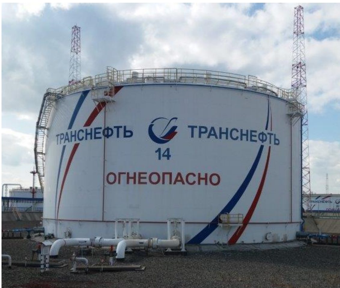
Рисунок 2 - Общий вид резервуара вертикального стального цилиндрического РВСPI-20000
